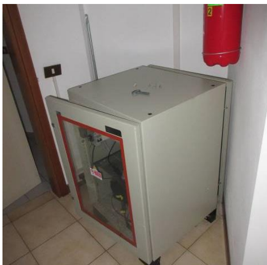
Armadio contenente il ricevitore ed il gruppo UPS
